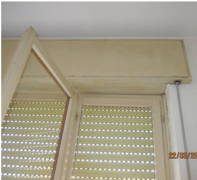
Tipologia serramento esistente, cassonetto e tapparelle.
