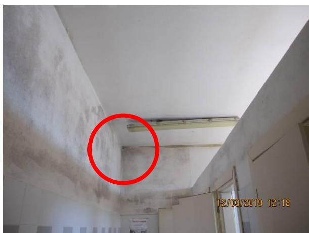
Muffe sulle murature perimetrali
