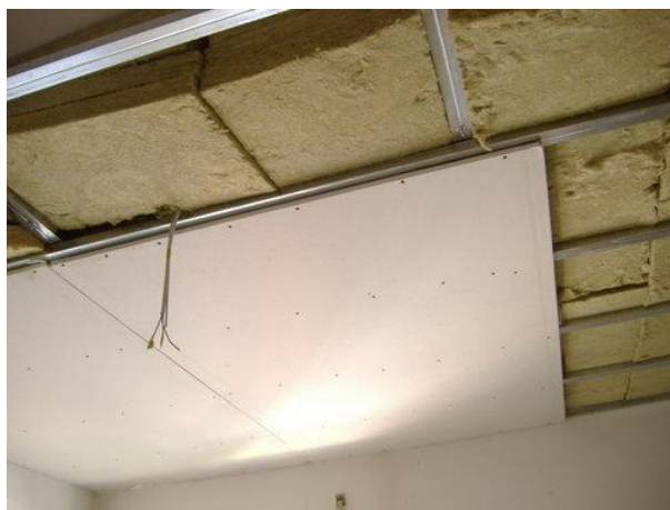
Tipologia rivestimento: lastra di cartongesso e lana di vetro doppia densità
