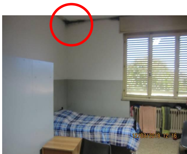
Muffe sulle murature perimetrali
