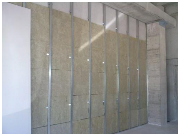
Tipologia rivestimento: rivestimento in cartongesso con lana di roccia e freno vapore.
